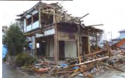
家屋倒壊現場解体中の家屋
