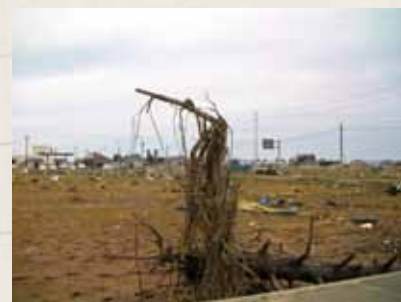
▲壊滅状態の若林地区
