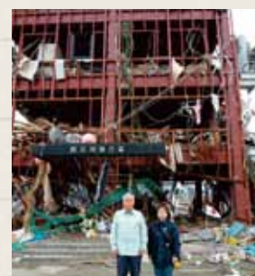
◀志津川庁舎前 3階建ての防災センターは鉄骨の残骸に…
